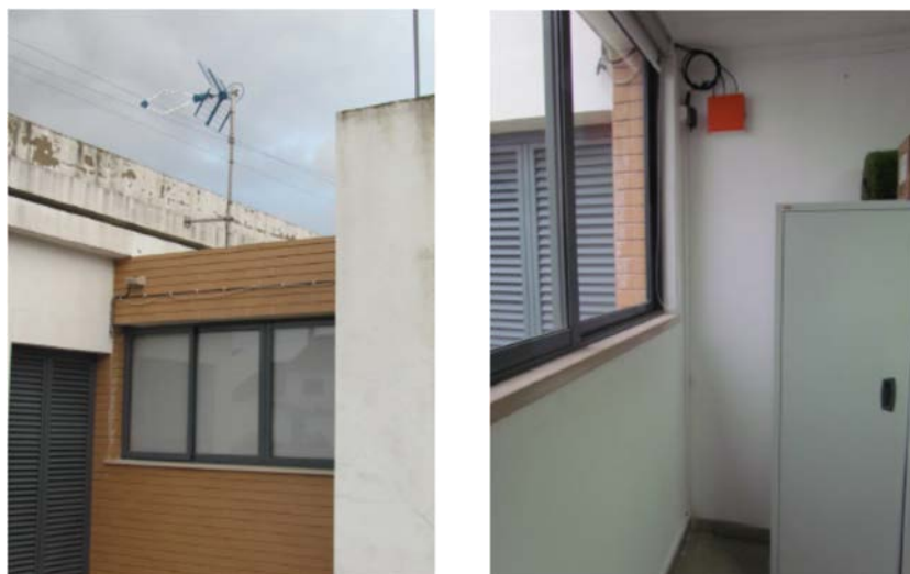
Slika 4.6 – Tipična merna lokacija na objektu za kolektivno stanovanje (stambena zgrada): (levo) antenski sistem, i (desno) unutrašnja instalacija sa mernom sondom, [32].
