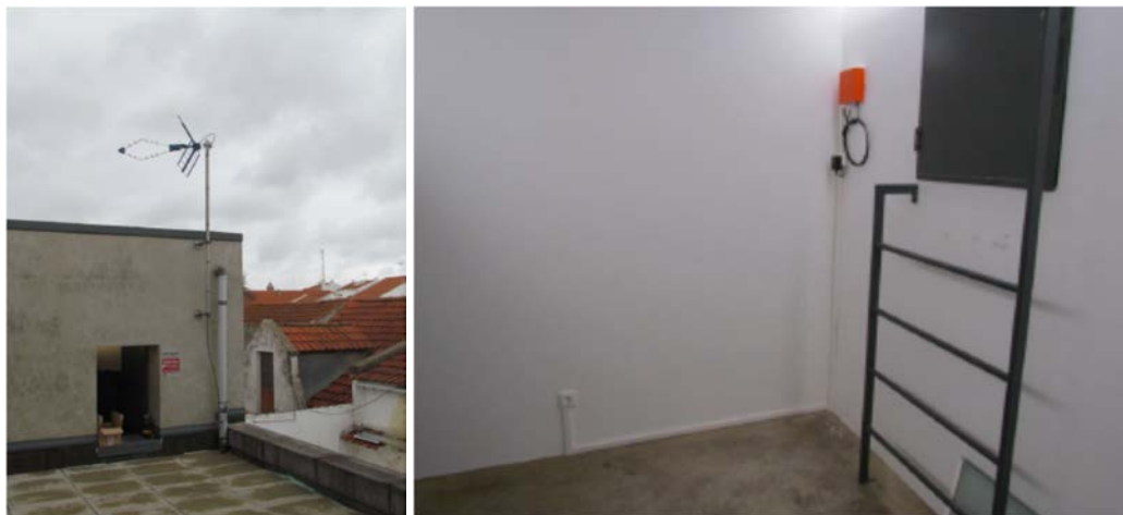
Slika 4.4 – Tipična merna lokacija na objektu manje visine (2-3 nivoa): (levo) instalacija antenskog sistema i (desno) unutrašnja instalacija sa mernom sondom, [32].
